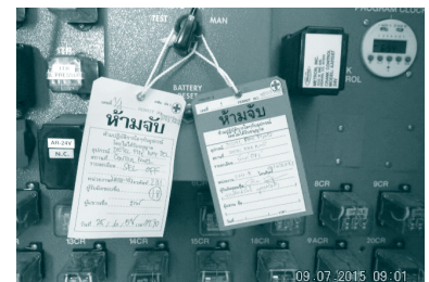
โรงไฟฟ้าราชบุรี
