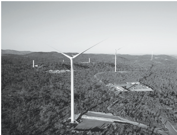
โรงไฟฟ้าพลังงานลมเมอร์ทอเมอร์ริล กำลังการผลิต 180.45 เมกะวัตต์ รัฐวิกตอเรีย ประเทศออสเตรเลีย
