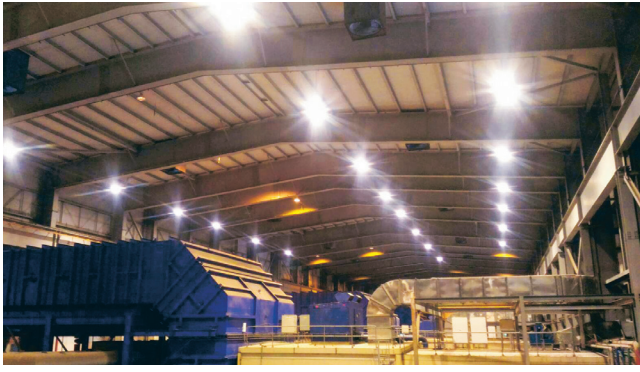
การติดตั้งโคมไฟ High Bay (LED) ณ โรงไฟฟ้าพลังความร้อนร่วม โรงไฟฟ้าราชบุรี
