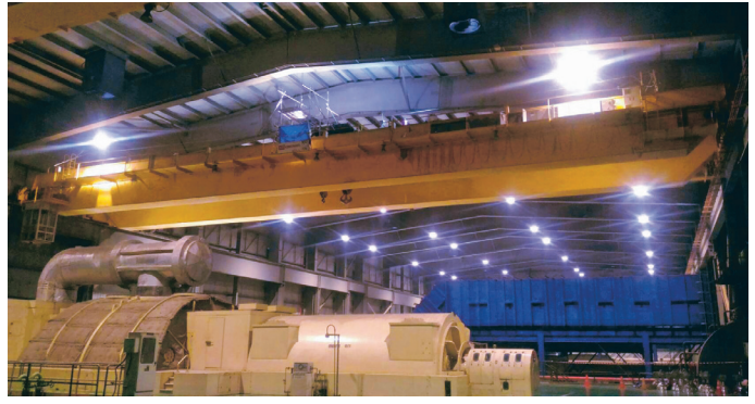
การติดตั้งโคมไฟ High Bay (LED) ณ โรงไฟฟ้าพลังความร้อนร่วม โรงไฟฟ้าราชบุรี
